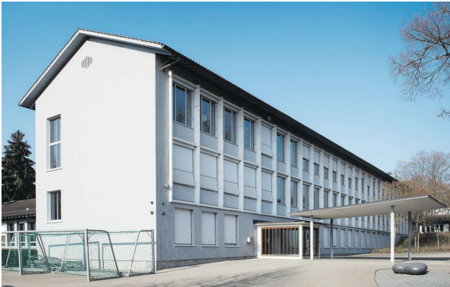
Bemerkenswerte Schulhäuser in Zürich: Erinnern die langgestreckte, reich detaillierte Rasterfassade und das Satteldach des 1953 von Roland Rohn in Höngg vollendeten Schulhauses Lachenzelg noch an die behäbige Variante des Landstils, so verströmt der leichtfüssige Eingang bereits den heiteren Optimismus der 1950er Jahre. KARIN HOFER / NZZ
